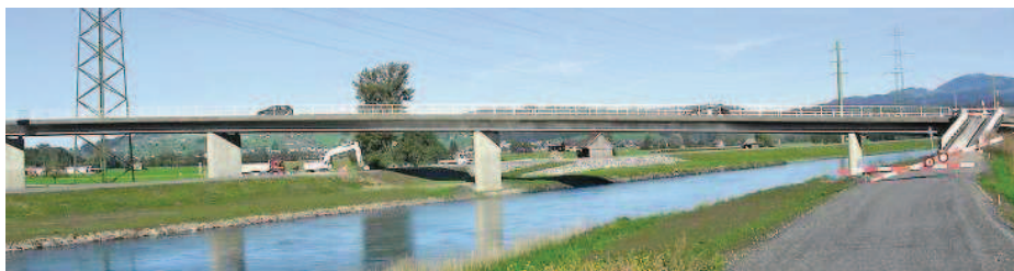
Für die letzten Sanierungsarbeiten an der Giessenbrücke wird die Strasse über den Lintthkanal an zwei Wochenenden gesperrt.
